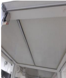
Fig. 3 Filtrele HEPA din tavan
